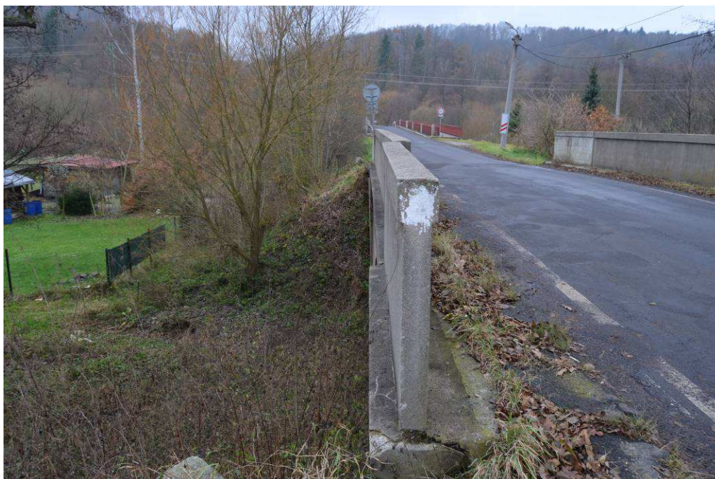
Podhled na pravou stranu mostu proti směru staničení – vykloněná křídla mostu
